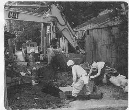
東町でも工事中
