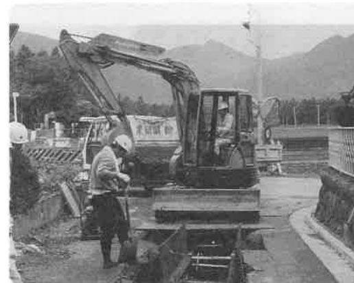
水沢野田町の工事現場
