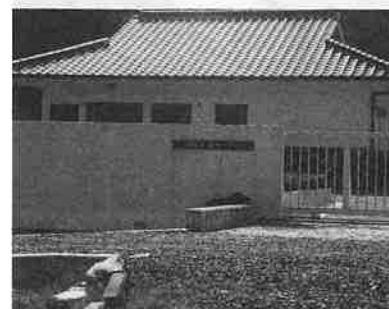
狭間浄化センター
