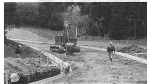
工事中の進入路
